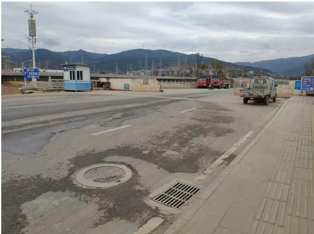
图 4-3 桥梁工程区排洪导流设施
