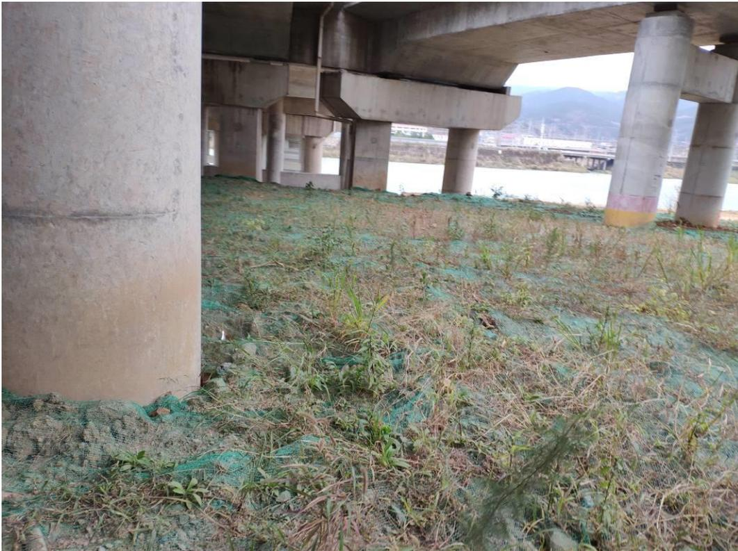
图 3-11 桥梁工程区防尘网苫盖
