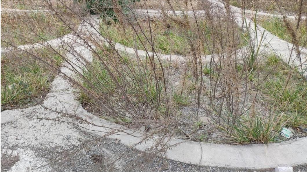
图 3-4 框格梁护坡
