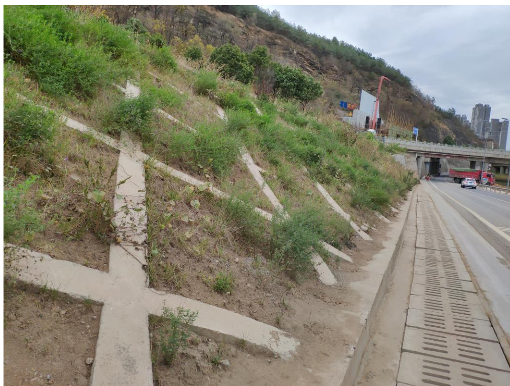
图 4-2 框格梁护坡
