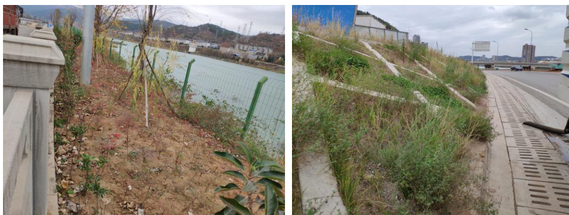
图 4-4 桥梁工程区植物措施现状
