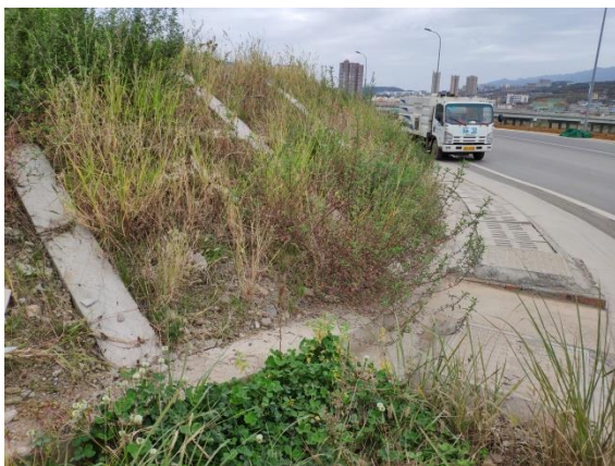
桥梁工程区绿化 4
