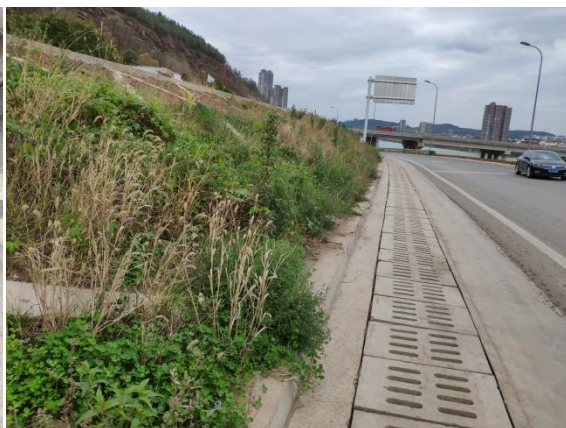
改线道路排水沟 2
