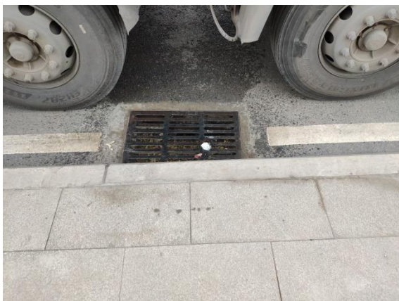
改线道路排水沟 1
