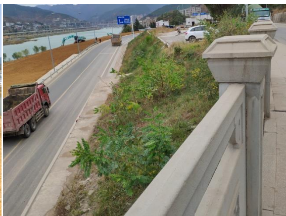
桥梁工程区绿化 1
