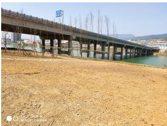
施工生产生活设施区土地整治
