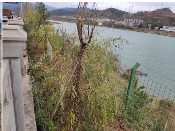
桥梁工程区绿化 5
