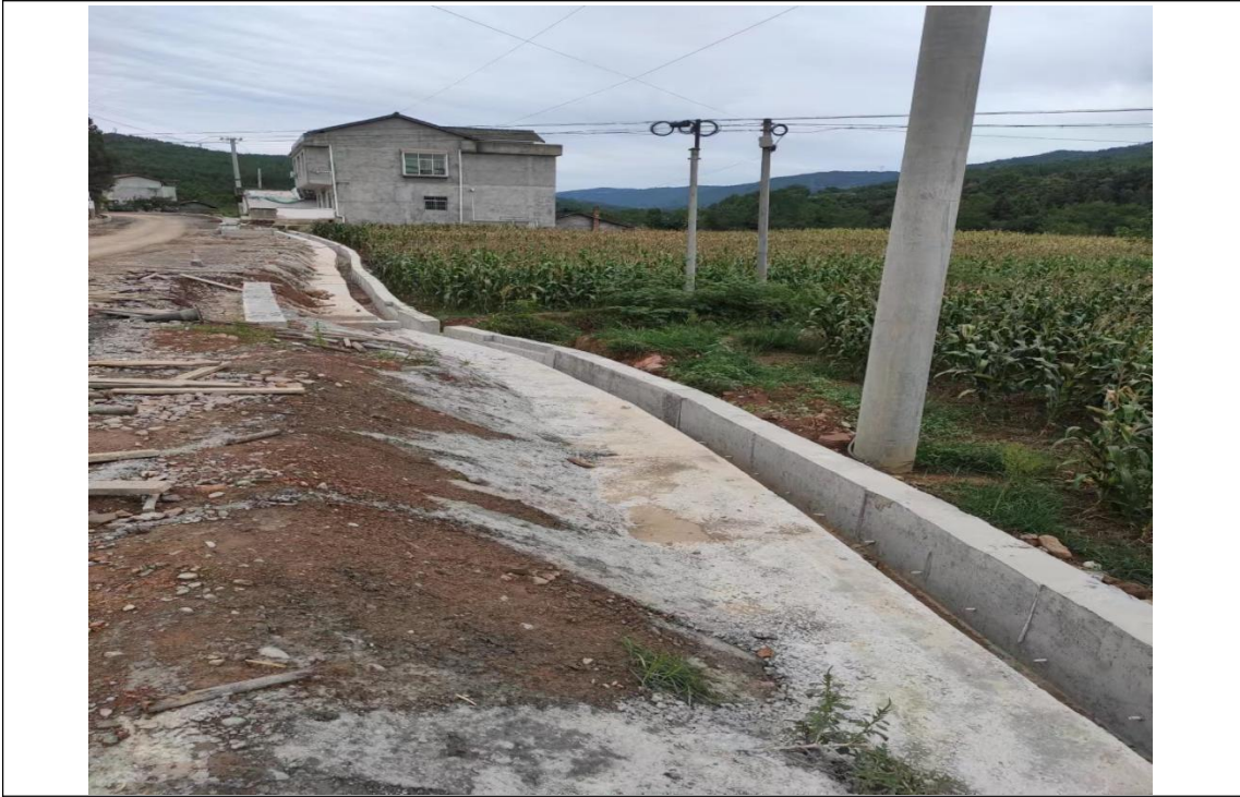
路基排水沟现状
